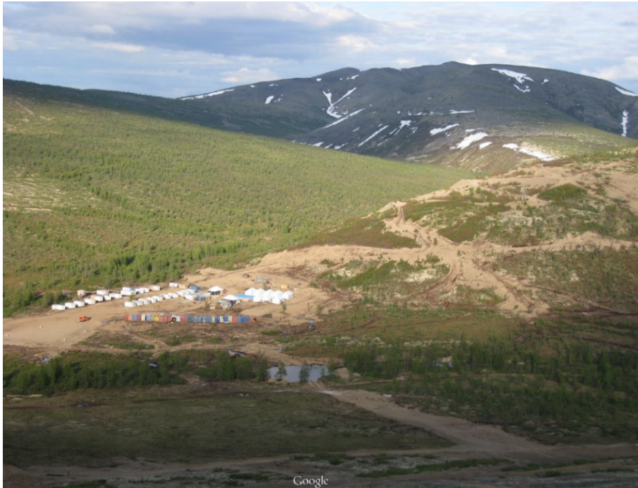
Рис. 2.16. Геолого-разведочные работы на месторождении Песчанка [32]
