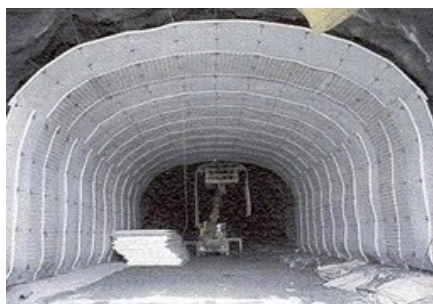
Изоляция горизонтальной выработки (пенополиэтиленом) [38]
