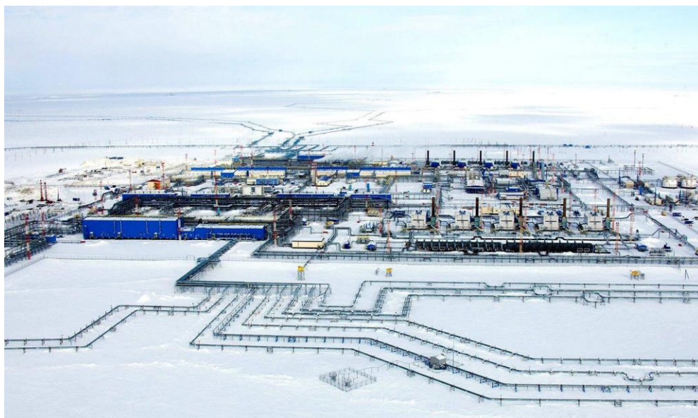
Рис. 5.6. Бованенковское месторождение (ПАО «Газпром»)
