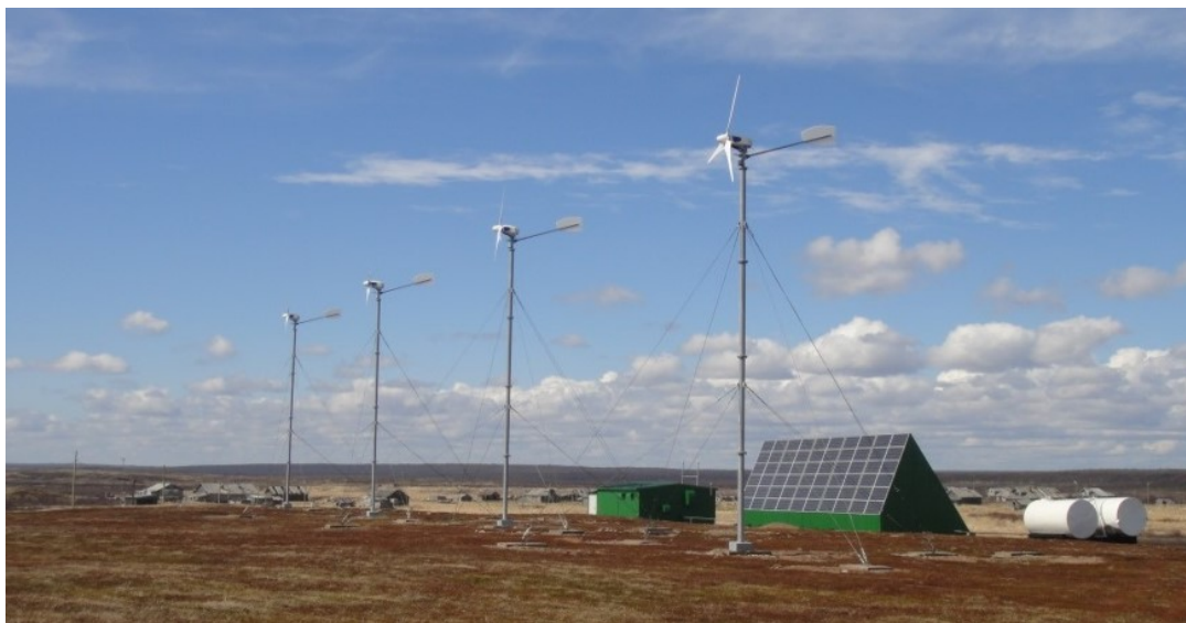
Рис. 22. Гибридная ветродизельносолнечная установка в с. Пялица на южном побережье Кольского полуострова. Введена в эксплуатацию в 2014 г.
