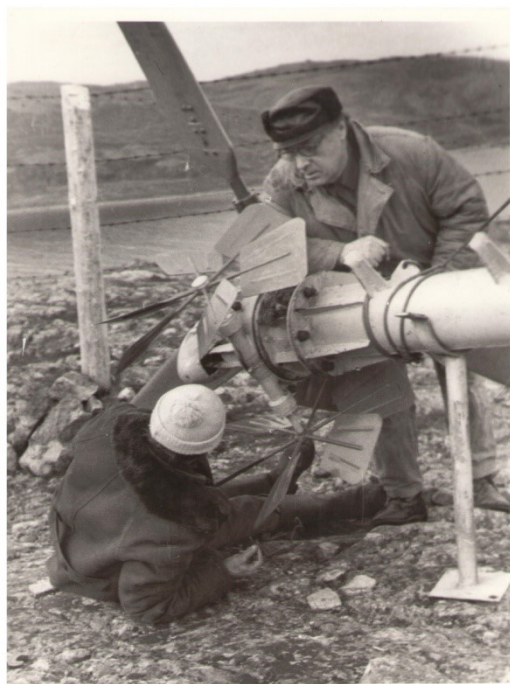
Рис. 3. Технический осмотр ветроагрегата «Ветерок» на полигоне в пос. Дальние Зеленцы Fig. 3. A technical inspection of the wind turbine “Veterok” at the test site in the settlement of Dalniye Zelentsy
