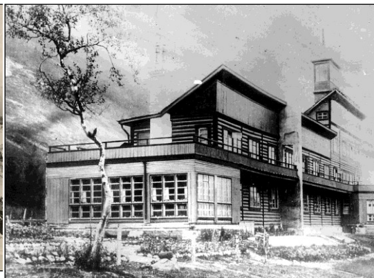
Рис. 8. Хибинская горная станция АН СССР «Тигетта» в Хибинах. 1930-е гг. [Музей-Архив, НВФ 1140а]
