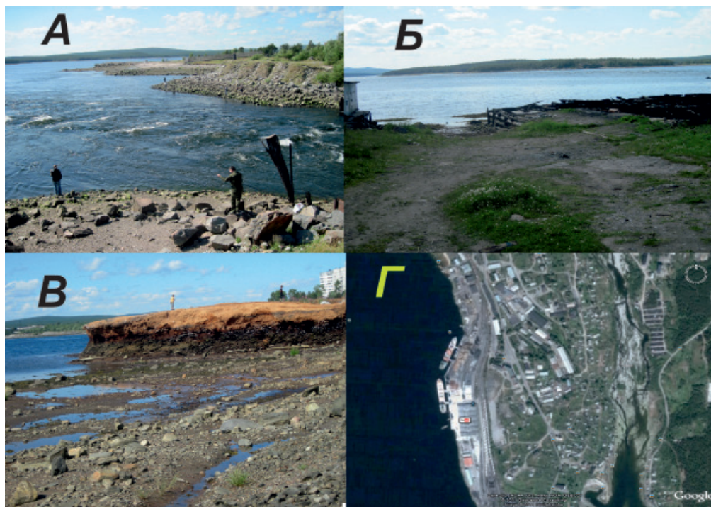
Рис. 32. Техногенные берега в районе города Кандалакша: А – устье водоотводного канала реки Нива; Б – берег, сложенный в основном древесной щепой; В – насыпной берег из опилок, активно размываемый морем; Г – берег, закреплённый стенкой Кандалакшского порта и далее к северу укреплённый валунами
