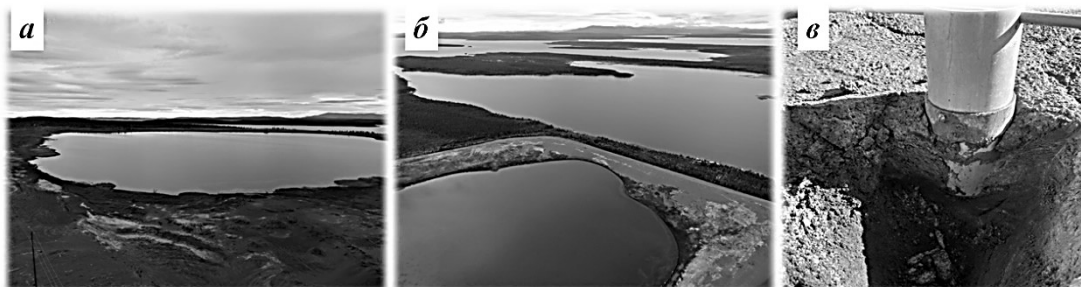
Рисунок 1. Вид на хвостохранилище медно-никелевых руд опытной ОФ (а), Хабозерскую губу оз. Имандра (б), отбор проб поверхностного слоя хвостохранилища методом режущего кольца
