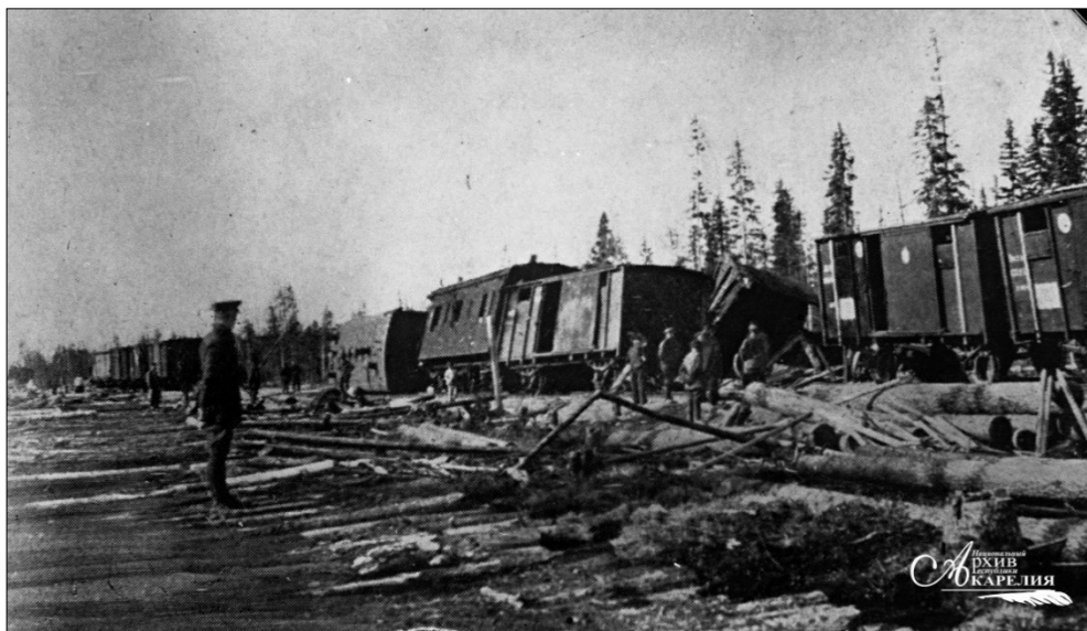
Рис. 5. Разрушенный во время военных действий участок Мурманской железной дороги. 1918 г. [фото из НА РК]
