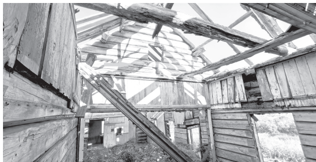
Рис. 23. Храм внутри. Трапезная. На рубленом фронтоне видны следы от старой крыши
