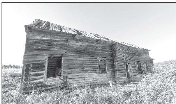
Рис. 21. Никольская церковь Порьей губы. Вид с юга
