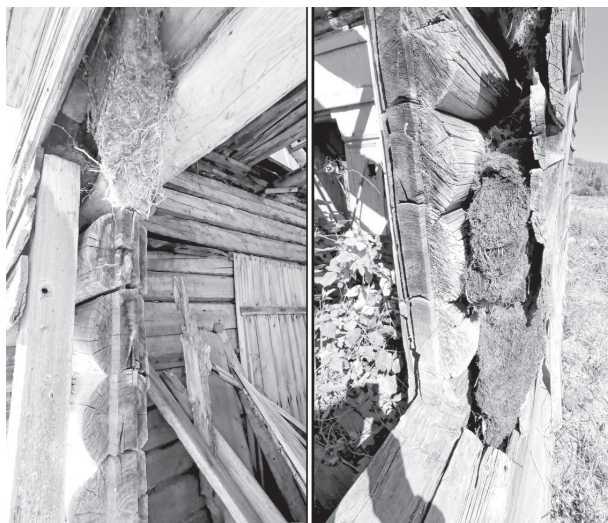
Рис. 26. Утепление сруба церкви мхом
