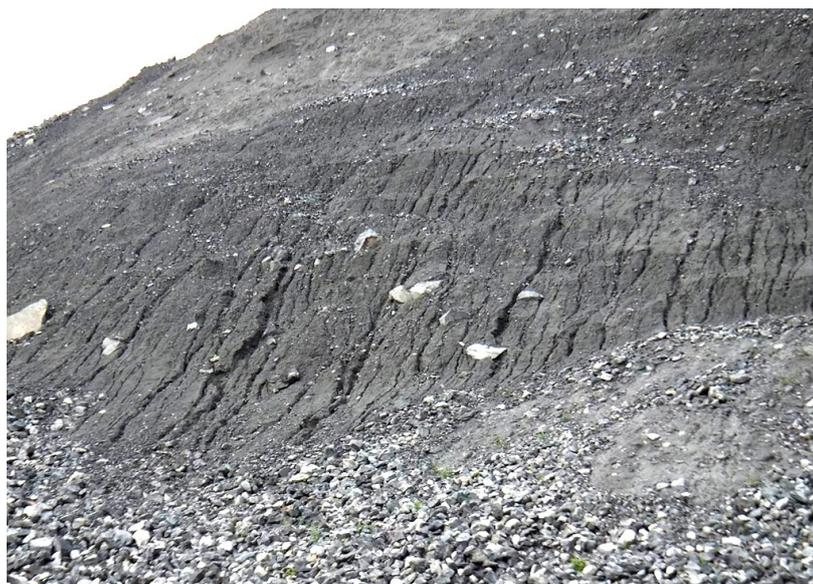
Рис. 3.16. Промоины мелкодисперсного грунта на откосе после осадков и таяния снега
