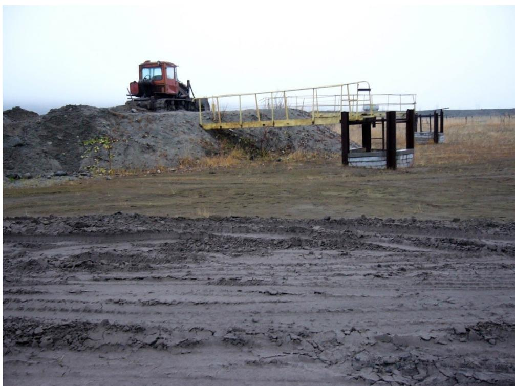
Рис. 2.27. Водосборные шандорные колодцы № 3 и № 4 на секции II
