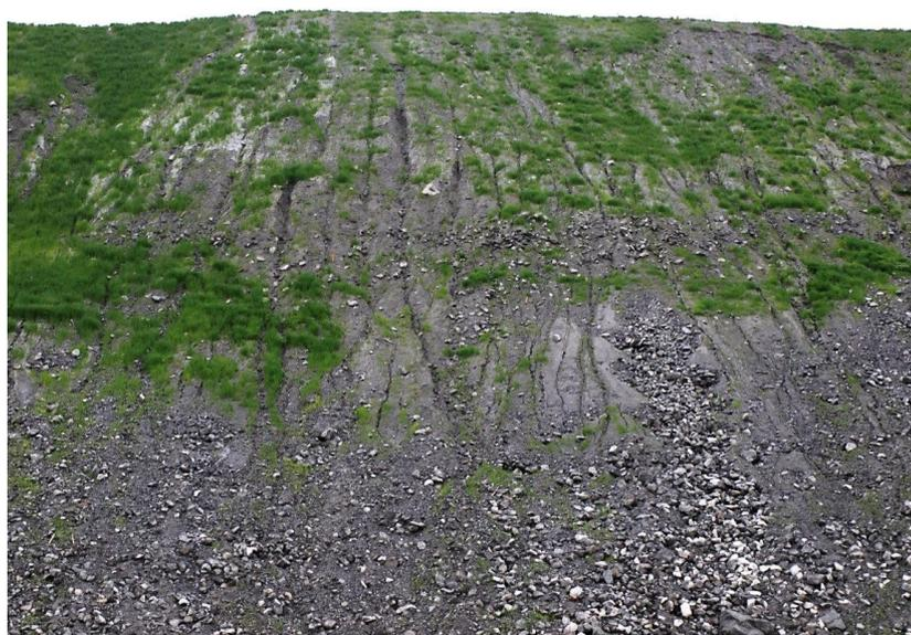
Рис. 3.17. Промоины на засеянном травостоем откосе опытного полигона отвала № 3 после больших дождей
