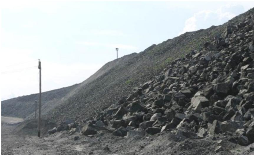
Рис. 3.14. Выравнивание крупнокусковой поверхности откоса среднекусовой скальной вскрышей
