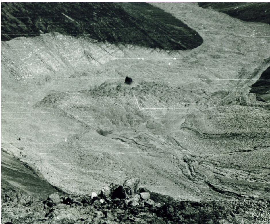
Рис. 3.3. Неконтролируемое обрушение отвала с откосов на Центральном руднике и движение горной массы между склонами вниз по долине на дальность до 4 км
