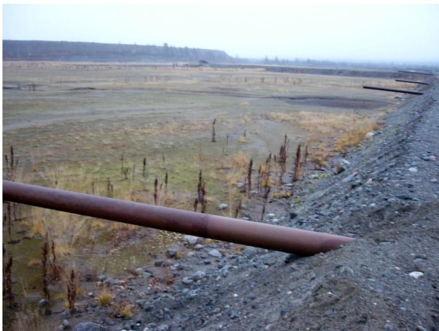
Рис. 2.26. Размещение пульповыпусков на ограждающей дамбе в сторону секции II
