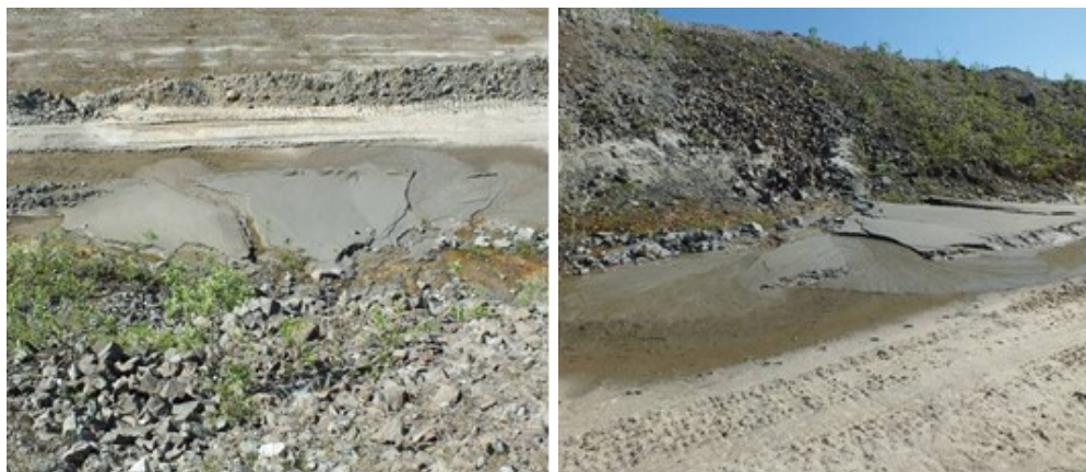
Рис. 5.3. След вымывания материала дамбы: а — вид сверху; б — вид сбоку
