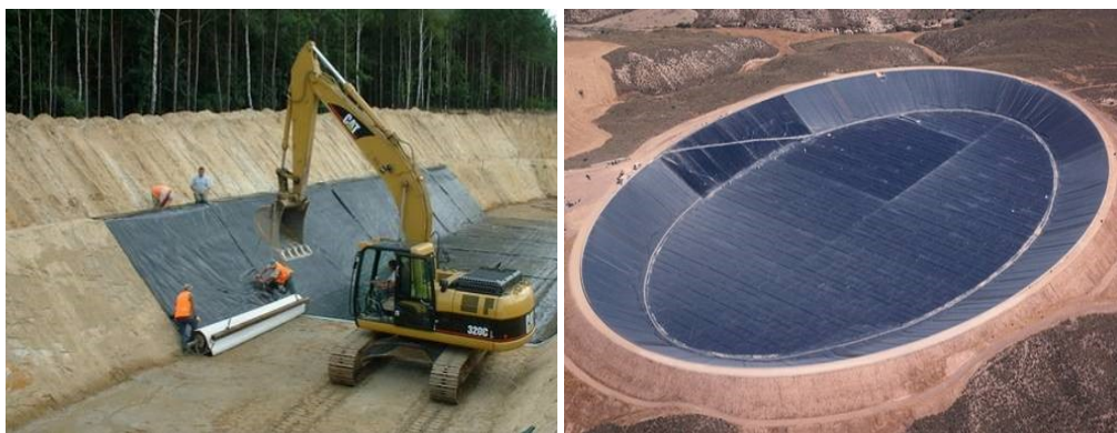
Рис. 7.8. Примеры использования бентонитовых геосинтетических матов (Использованы фотографии с сайта https://geomembrana.lc-umi.ru/ )
