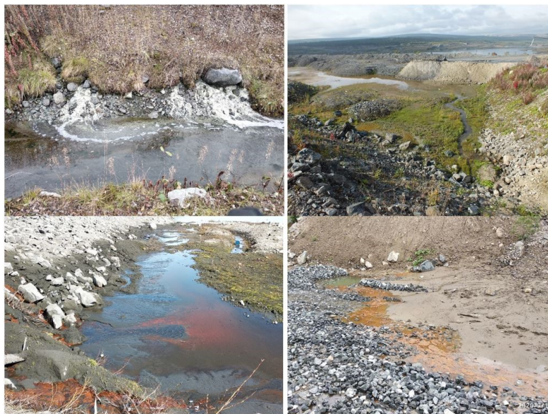
Рис. 5.27. Выходы фильтрующихся вод на поверхность дамб
