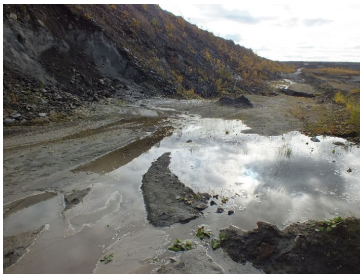
Рис. 5.1. Локальный выход фильтрующихся вод на поверхность полки ГТС
