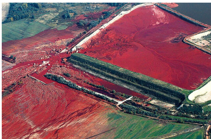
Рис. 1.9. Разрушение ограждающей дамбы хранилища жидких промышленных отходов завода Ajkai Timfoldgyar Zrt, Венгрия. (Фото: enactwi.files.wordpress.com) [23]
