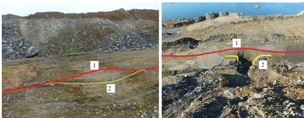
Рис. 5.19. Деформации поверхности насыпного ГТС: 1 — линия первоначального локального поднятия; 2 — линия последующего локального оседания и обрушения
