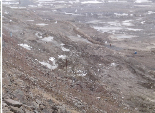
Рис. 5.31. Динамика деформирования поверхности полки в период май 2013 г. – май 2014 г.
