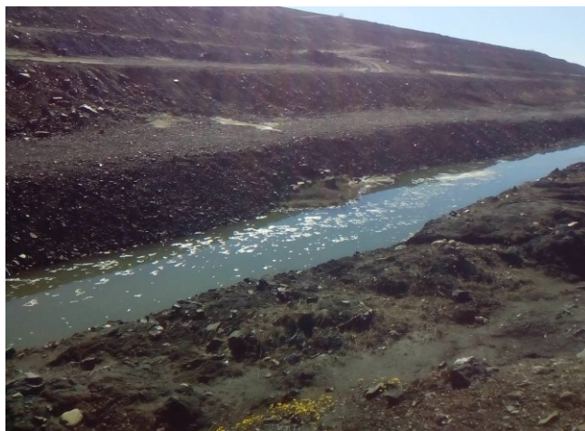
Рис. 5.14. Водоулавливающая канава у основания ГТС
