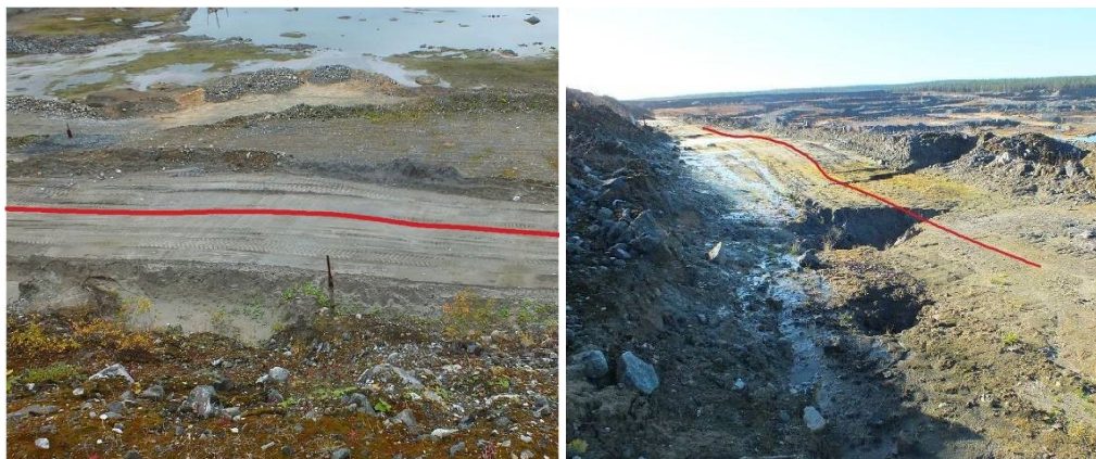
Рис. 5.18. Локальные поднятия поверхности насыпного ГТС
