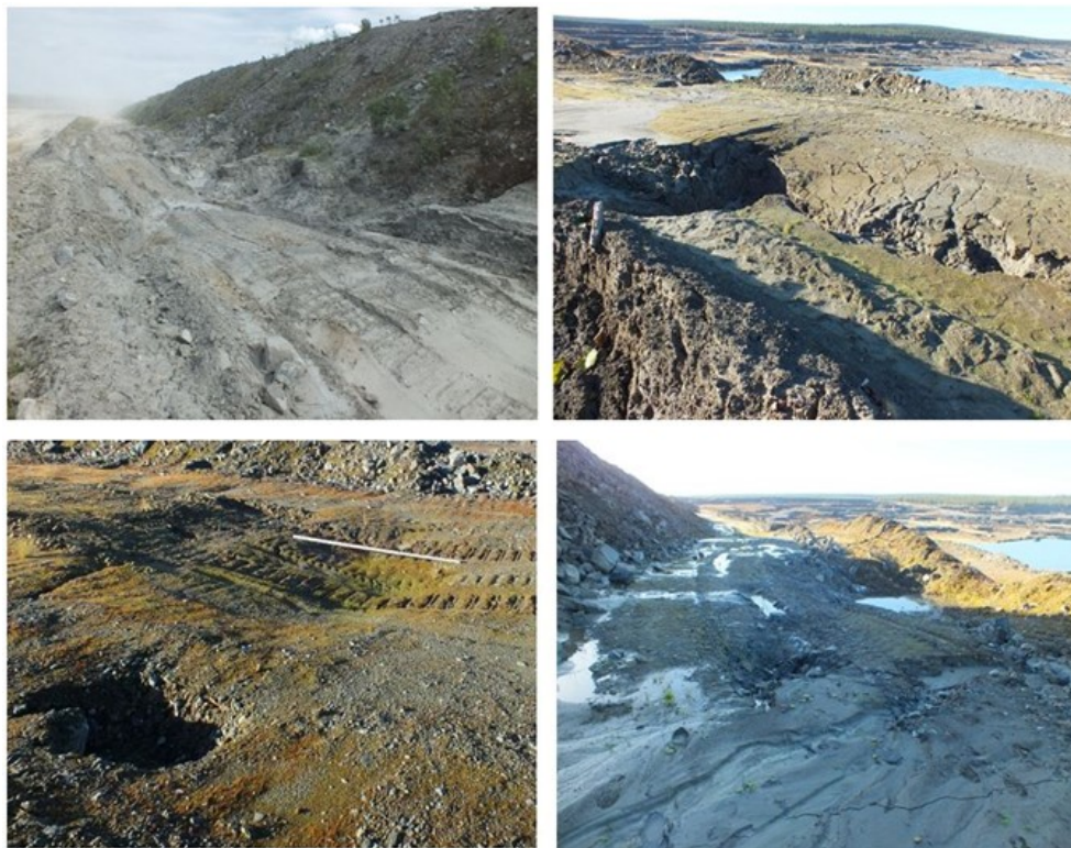
Рис. 5.25. Примеры наблюдавшихся локальных проседаний поверхности полков обследованных ГТС
