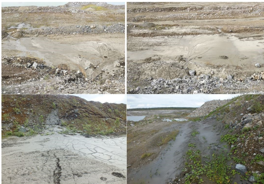
Рис. 5.24. Выходы фильтрующихся вод на поверхность дамбы
