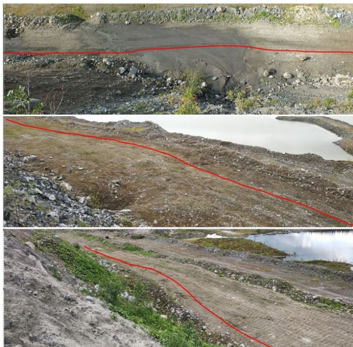
Рис. 5.26. Поднятия поверхности полок насыпного ГТС
