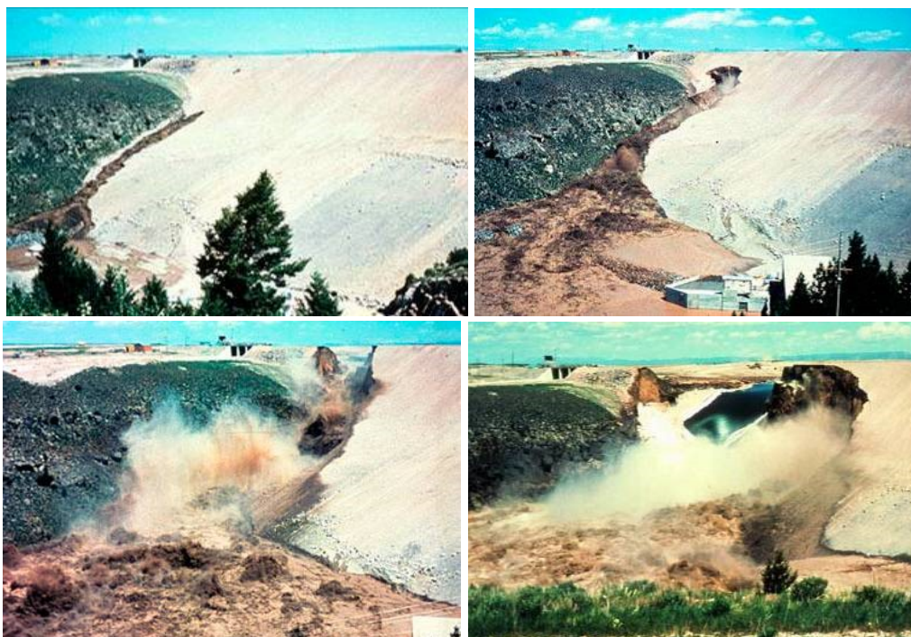
Рис. 5.4. Разрушение плотины «Титон» 5 июня 1976 г. [232]
