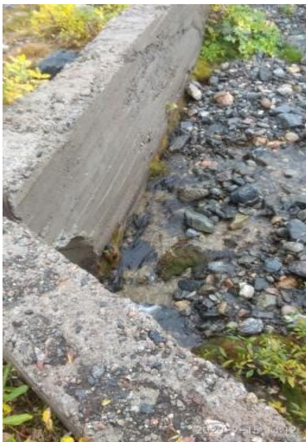
Рис. 4.13. Железобетонная конструкция (ЖБИ 1)
