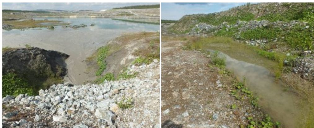
Рис. 5.20. Выходы фильтрующихся вод на поверхность: а — у основания ГТС; б — на поверхности полки
