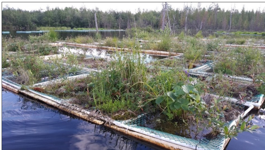
Рис. 23. Фитоценоз на плавающих биоплатах, созданных на Кировогорском пруде-отстойнике (г. Оленегорск, Мурманская область, РФ) с помощью ковровой дернины
