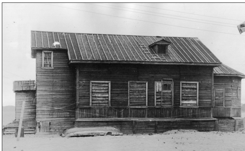
Рис. 1. Здание бывшей церкви Грузинской иконы Божией Матери в селе Териберка. 1969 год. Вид с юга. Фото В. Н. Гурьева
