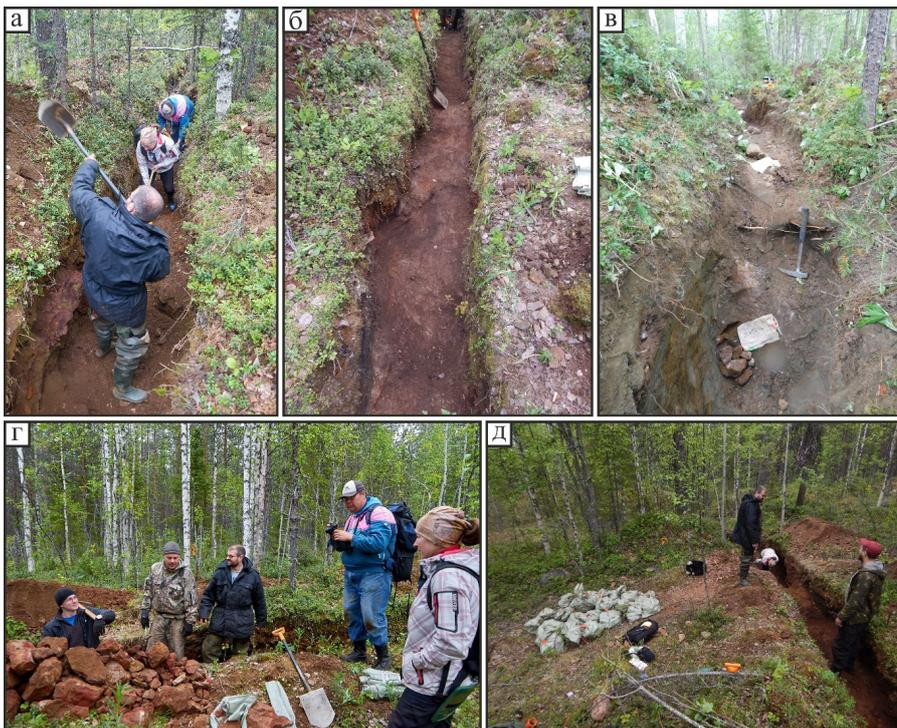
Рис. 2. Разведочные канавы, из которых отбирались образцы карбонатитов. (а) Процесс подновления канав и (б) полученный результат. (в) Фотодокументация пробоотбора. (г) Отбор технологической пробы анкилитовых карбонатитов (красные породы на переднем плане) и (д) подготовленная проба.
